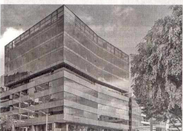
AR Hoteles, compañía del Grupo AR, inauguró Torre EAR, edificio con oficinas y centro de convenciones en el enclave de la calle 100 con carrera 15 de Bogotá, donde el grupo ha concentrado su inversión para el mercado corporativo, con una inversión cercana a los 50.000 millones de pesos.
